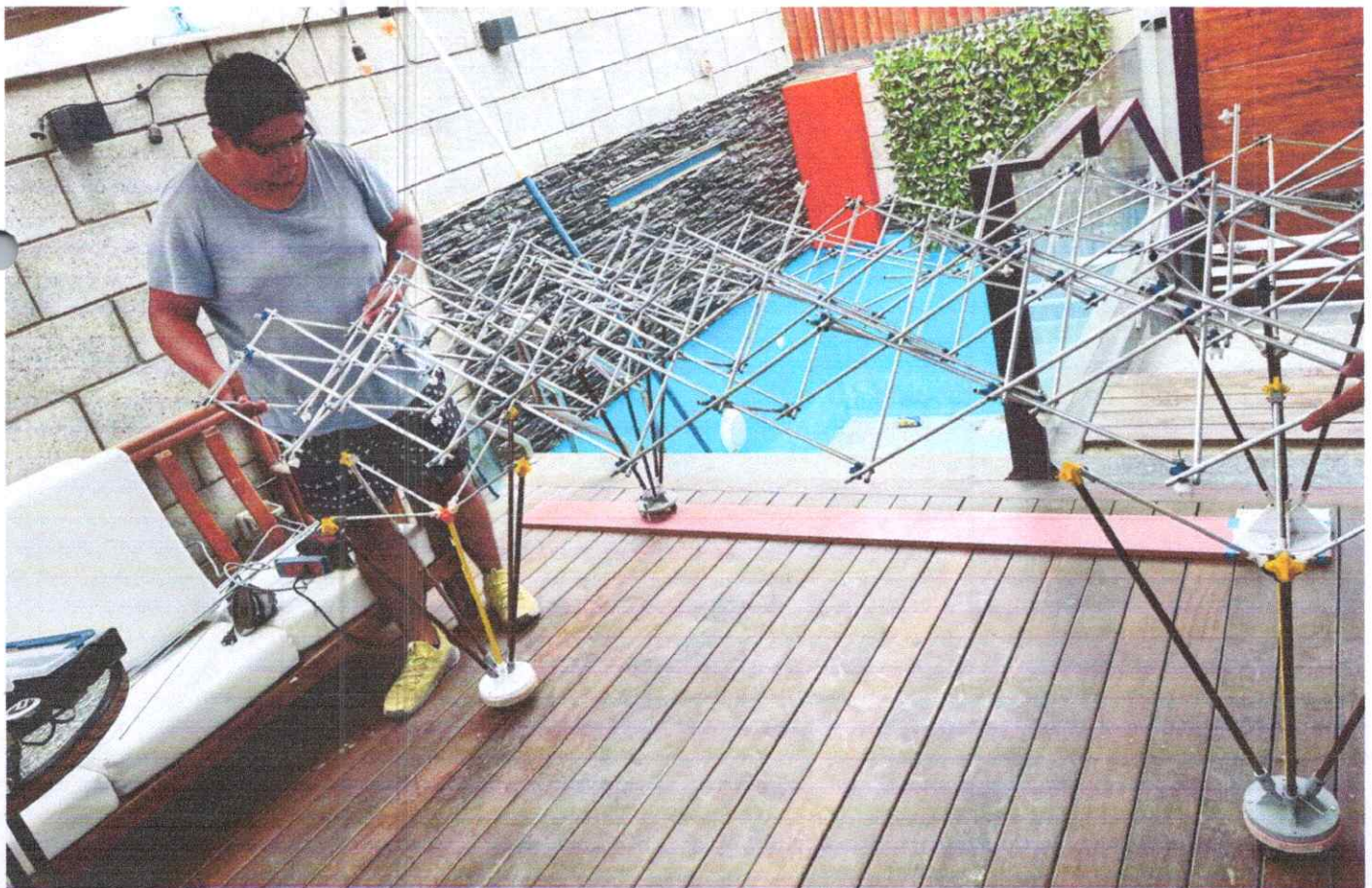
Figura 19.0. Ensamblaje de módulos de tetraspas hacia los apoyos. Fuente: Elaborado por el autor
