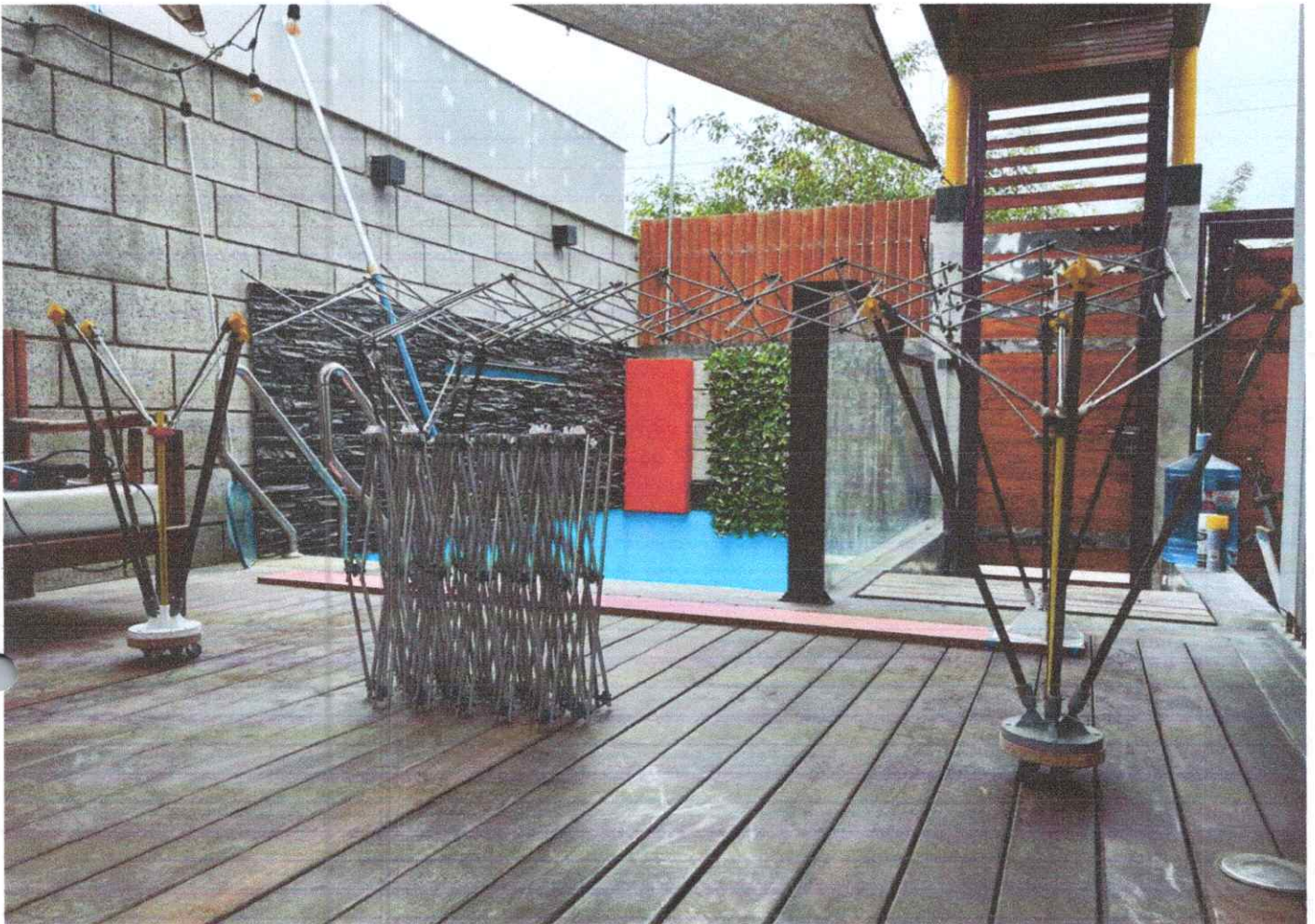
Figura 18.0. Ensamblaje de módulos de tetraspas hacia los apoyos. Fuente: Elaborado por el autor
