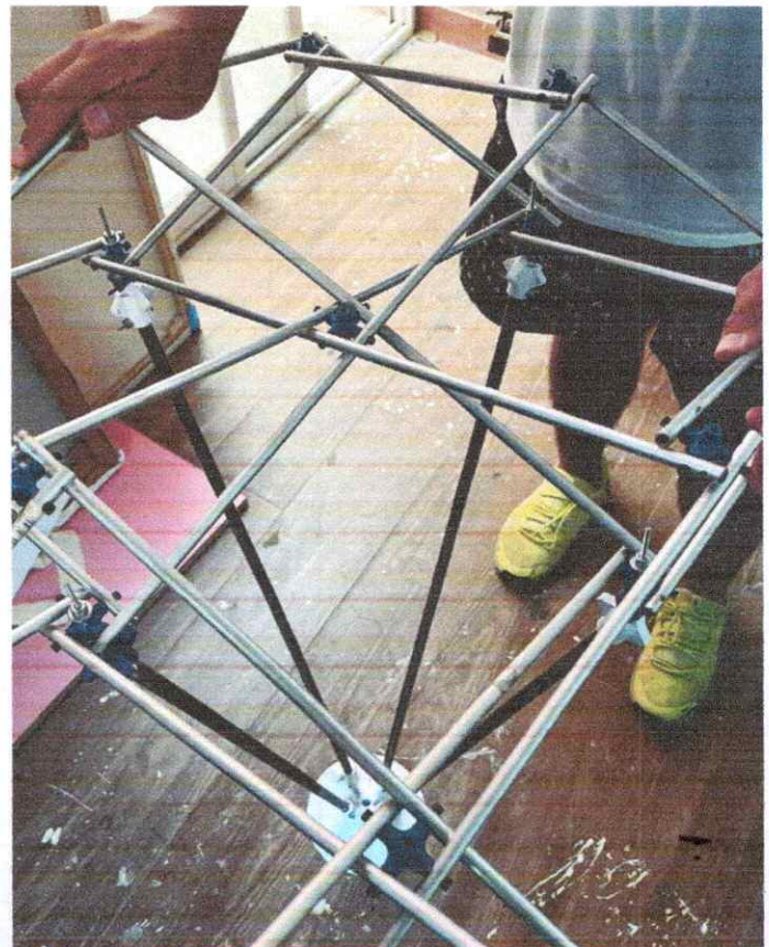
Figura 17.0. Ensamblaje de tetrapas en las patas de apoyo de la estructura. Fuente: Elaborado por el autor
